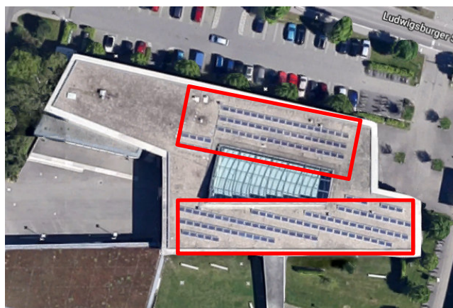
Abbildung 20: PV-Anlage des Standortes Sachsenheim
