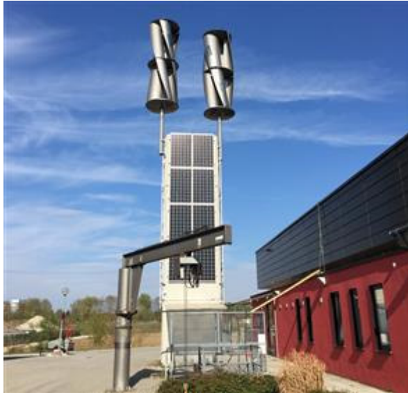
Abbildung 66: Savonius Windturbine (Energieagentur Ebersberg - München, 2018)
